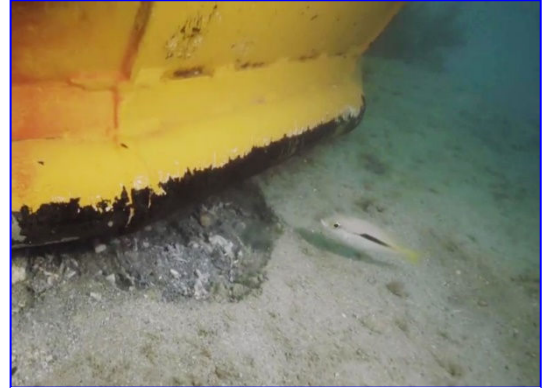
浚渫作業中の海底(水中)
