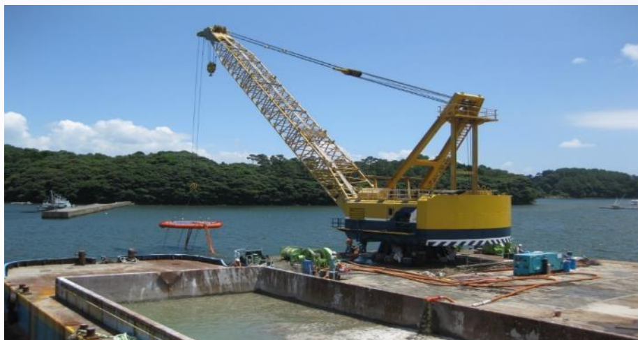
底質を除去し土運船へ揚泥
