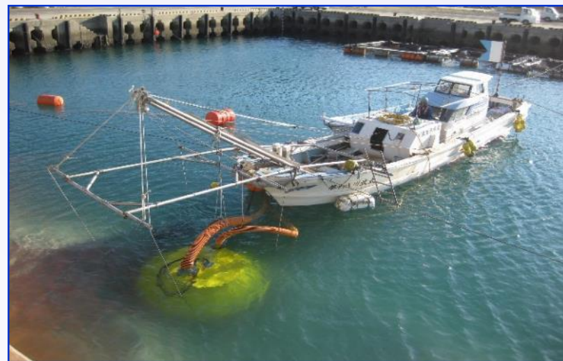
潜水土船に設置
