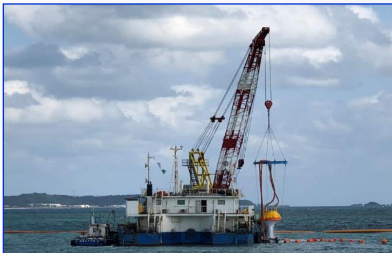
クレーン船に設置
