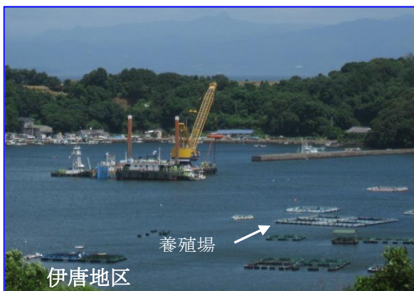
図-7 伊唐地区 養殖場近くでの施工状況
